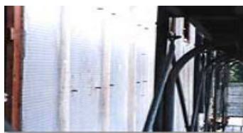
脱型後シートを残す
